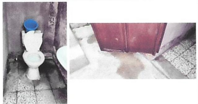
Foto 7 y 8: Mantenimiento a estructura (lijado, cambio de tubo , cepillado, sujeciones, aplicacion de pintura) a puertas servicios sanitarios y sustitucion de inodoro
