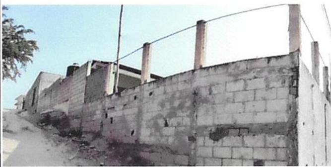
Foto1: Reparación de muro perimetral, area de patio 1 y 2 en colocacion de cernido con sabieta y cambio de malla
